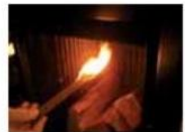
Рис. 2. Проверка тяги дымохода
